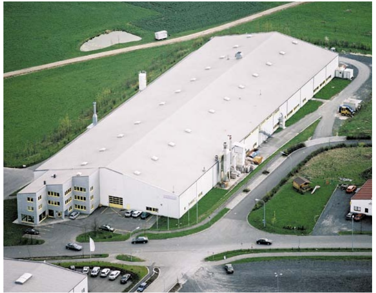
▲ „Manufaktur-Fabrik“: 1994 zog die Zehendner-Fertigung in einen wesentlich größeren Neubau um.
